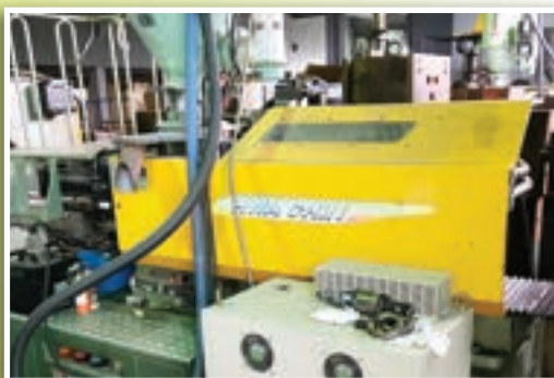
改善後新設變頻裝置60HP
