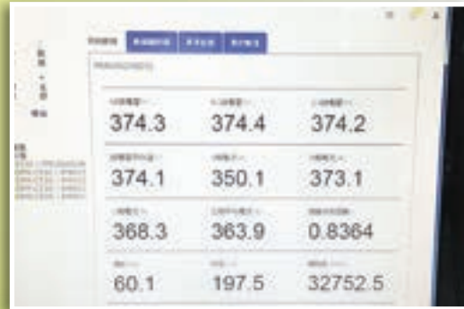
改善後新設空壓監控系統
