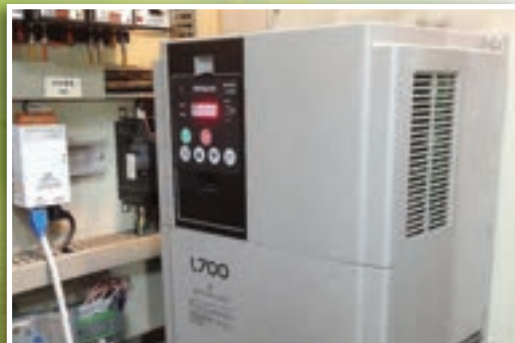
改善後新設變頻設備
