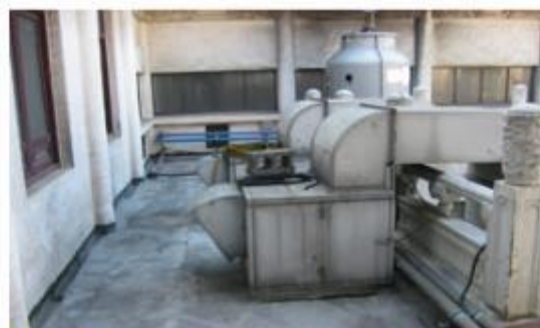
改善前，另設排風系統(後拆除)
