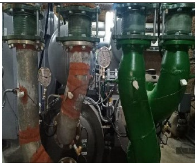
112 年臺中榮民總醫院；總工程款 1200 萬，補助款 4,00 萬，節能率 47%。 工程內容汰換 250RT 冰水主機*1 台、180RT 冰水主機*1 台及附屬設備。
