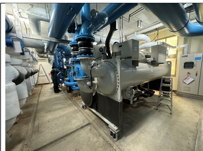
110 年國軍台中總醫院；總工程款 800 萬，補助款 240 萬，節能率 42.86%。 工程內容汰換 450RT 主機及附屬設備(冷卻水泵及冰水泵)。
