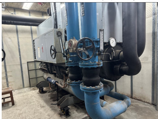
113 年東海大學圖書館；總工程款 1848.5 萬，補助款 500 萬，節能率 49.2%。 工程內容汰換 300RT 冰水主機*2 台及附屬設備。
