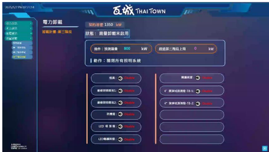
【竣工照片－EMS 能管系統：須量卸載計畫-第三階段 關閉照明】
