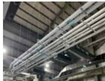
空調配管施工
